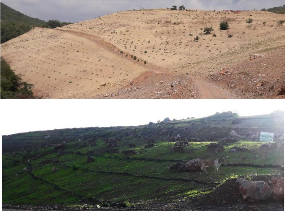
Figura 3.- Taludes de tepetateras perfilados, hidrosembados, reforestados y con controles de erosión colocados a curvas de nivel.
