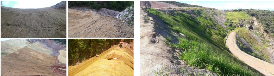
Figura 2.- Taludes controlados con malla de coco e hidrosiembra en sección noreste de tepetatera Bermejil Norte.
