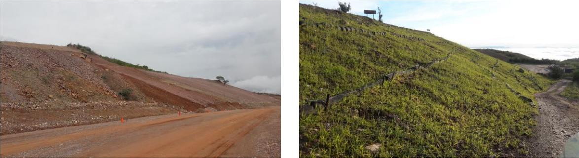
Figura 1.- Cierre de taludes en tepetatera Filos con controles de erosión, hidrosiembra de pastos y árboles de la región.
